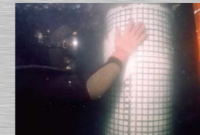
水中適用形炭素繊維グリッド補強工法 コンクリート杭への施工例
