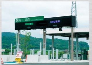
ETCトールゲート製作・施工
