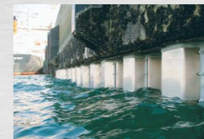
チタンカバー・ペトロラタム被覆工法(TP工法) 鋼矢板への施工例
