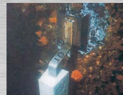
陽極取付状況
