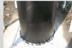
地際補修工法 鋼製支柱への施工例
