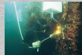
流電陽極方式電気防食工法 鋼矢板への施工例
