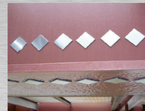
腐食減耗量測定(ワッペン試験法)
