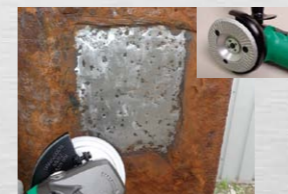
耐候性鋼橋梁塗装技術(ダイヤツール) 作業状況
