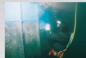
水中施工形被覆工法(バテタイプ) 鋼矢板への施工例
