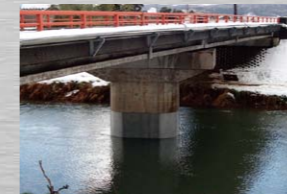
水中適用形炭素繊維グリッド補強工法 コンクリート橋脚への施工例
