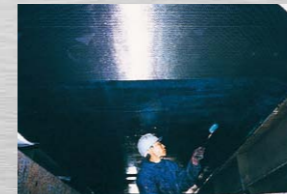
炭素繊維補修補強工法 橋梁床版への施工例
