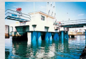
FRPカバー・ペトロラタム被覆工法 (NTAC-FP工法)/鋼管杭への施工例
