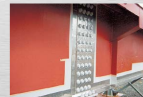
チタン箔による橋梁塗膜の補強工法 橋梁への施工例
