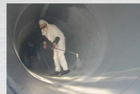
エネルギー配管内面防食工法 配管内施工例
