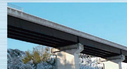
耐候性鋼橋梁
