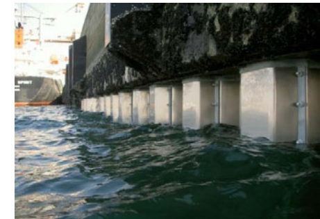
鋼矢板のチタン被覆
