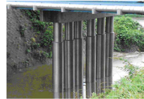
パイルベントのチタン被覆
