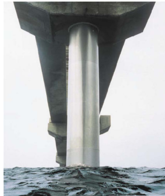
鋼管杭のチタン被覆
