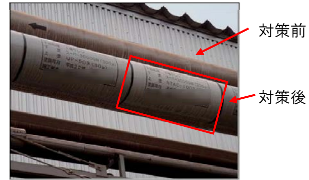
温間配管防汚:変性エポ+NTAC-1000
