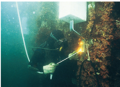
陽極の取付状況
