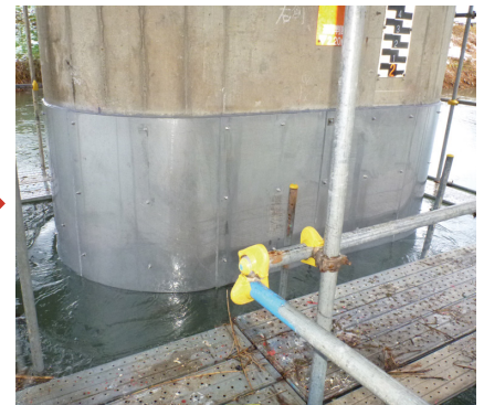
③ 樹脂注入完了
