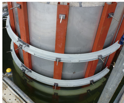
② SUS型枠組立中
