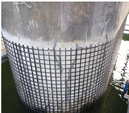
① CFRPグリッド設置
