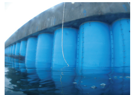
鋼管矢板の施工例
