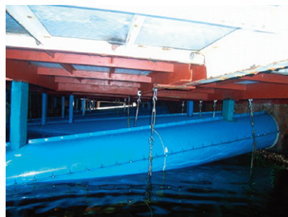
棧橋繋ぎ梁の施工例
