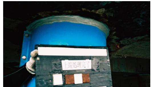
4. 水中硬化形エポキシ樹脂による端部処理
