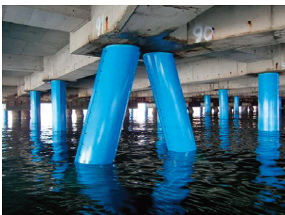
鋼管杭の施工例
