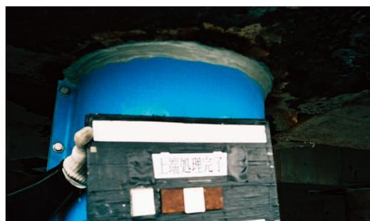
4. 水中硬化形エポキシ樹脂による端部処理
