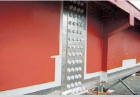
チタン箔による橋梁塗膜の補強工法 橋梁への施工例
