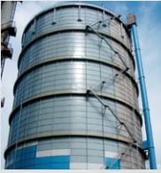
軽ケレン防食工法 ガスホルダーへの施工例
