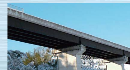
耐候性鋼橋梁
