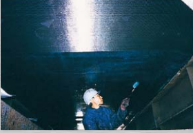
炭素繊維補修補強工法 橋梁床版への施工例
