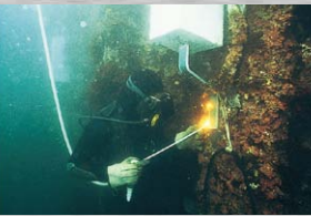
流電陽極方式電気防食工法 鋼矢板への施工例
