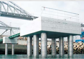
チタンカバー・ペトロラタム被覆工法(TP工法) 鋼管杭への施工例
