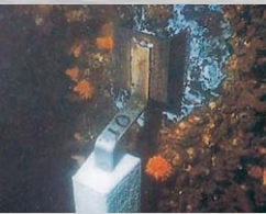
陽極取付状況
