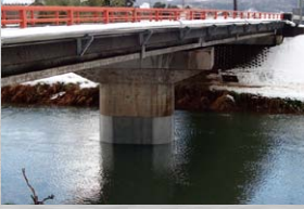
水中適用形炭素繊維グリッド補強工法 コンクリート橋脚への施工例
