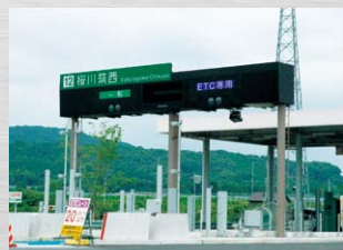
ETCトールゲート製作・施工
