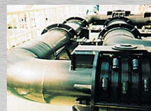
水道管 (ポリウレタン被覆)
