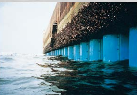
FRPカバー・ペトロラタム被覆工法 (NTAC-FP工法) / 鋼矢板への施工例
