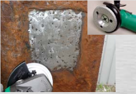
耐候性鋼橋梁塗装技術(ダイヤツール) 作業状況
