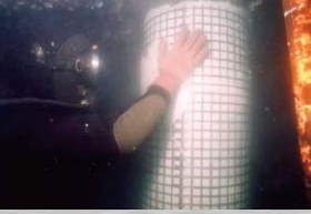
水中適用形炭素繊維グリッド補強工法 コンクリート杭への施工例
