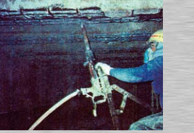
補修工法 コンクリート梁への施工例
