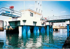
FRPカバー・ペトロラタム被覆工法 (NTAC-FP工法) / 鋼管杭への施工例
