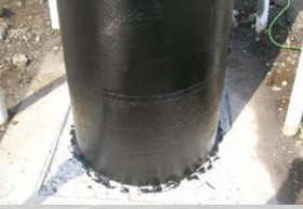
地際補修工法 鋼製支柱への施工例
