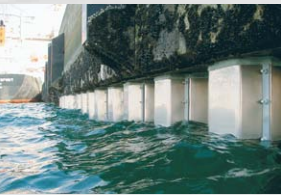
チタンカバー・ペトロラタム被覆工法(TP工法) 鋼矢板への施工例
