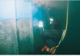
水中施工形被覆工法(バテタイプ) 鋼矢板への施工例
