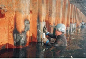
鋼板溶接工法 鋼矢板への施工状況
