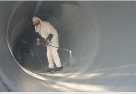
エネルギー配管内面防食工法 配管内施工例
