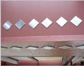
腐食減耗量測定(ワッペン試験法)
