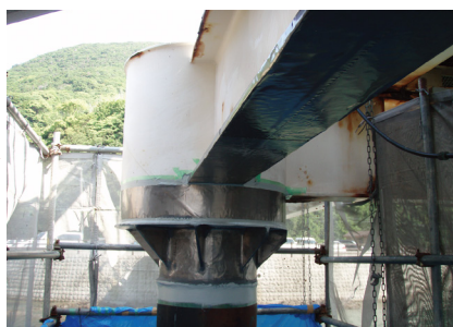
チタン箔シート貼り付け
