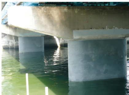
橋梁基礎への施工例
