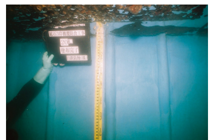
防食被覆完了
