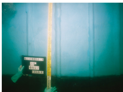
鋼矢板被覆状況(水中)
