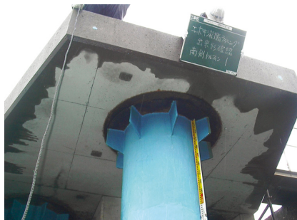
栈橋鋼管杭への施工例
