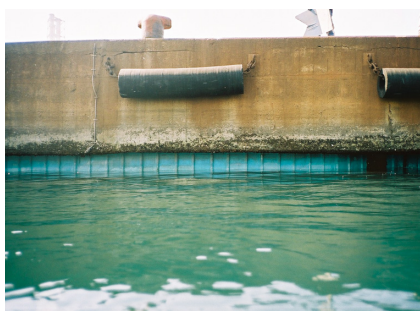
岸壁鋼矢板への施工例
