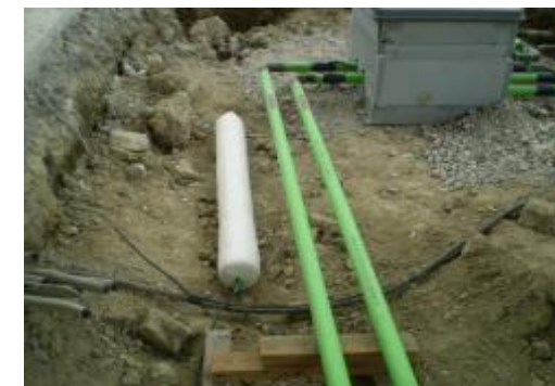
土中埋設物への適用 (マグネシウム合金陽極)
