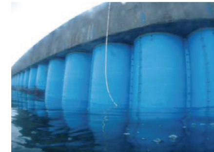
鋼管矢板への施工例
