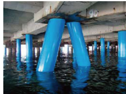
鋼管杭への施工例
