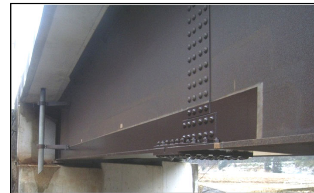
補修(部分)塗装完成
