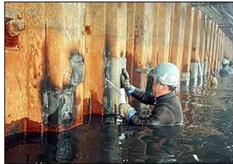
水中・気中溶接
