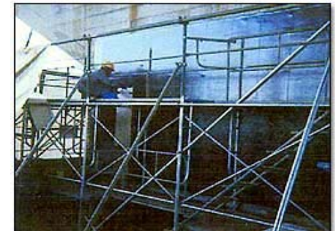
橋脚耐震補強
