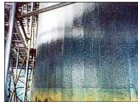
煙突劣化補強
