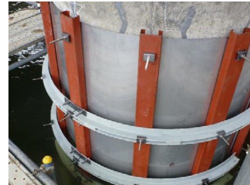
SUS型枠の組み立て
